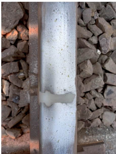
Rys. 7. Powierzchnia główki szyny po zastosowaniu komponentu minimalizującego tarcie Belzona [fot. S. Grulkowski]
