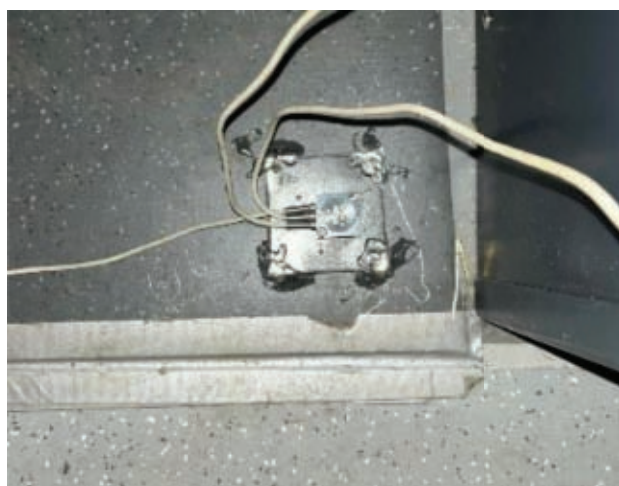
Rys. 10. Punkt pomiarowy 2 zlokalizowany na podłodze pociągu [fot. A. Łomżyńska]
