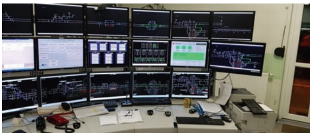
Rys. 4. Lokalne centrum sterowania wyposażone w RBC [źródło własne]
