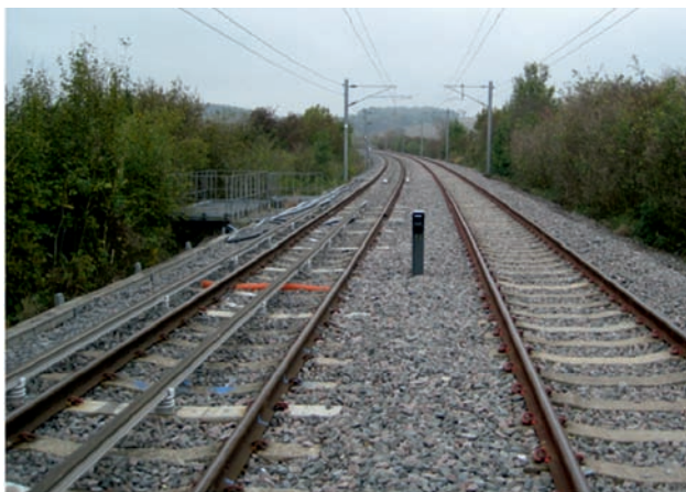
Rys. 14. Tory doświadczalne Melton Rail Innovation & Development Centre – lewy tor jest przystosowany do badań taboru metra zasilanego z trzeciej szyny [źródło: www.railway-technical.com ]
