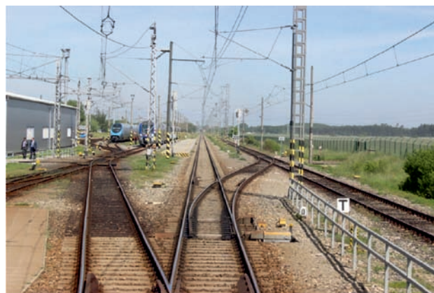
Rys. 7. Okrąg doświadczalny VUZ w Velimiu – odcinek prosty z rozjazdami oraz stacja techniczna [fot. A. Massel]
